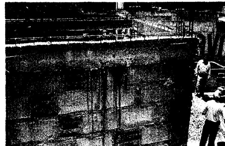
**Materiales: Concreto armado, block y tabique rojo recocido**
